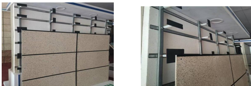
图 6.4.1 灌注有横向设置龙骨保温系统基本构造示意
